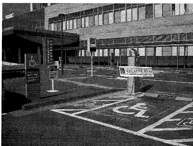
図9 身体障害者用駐車システム
